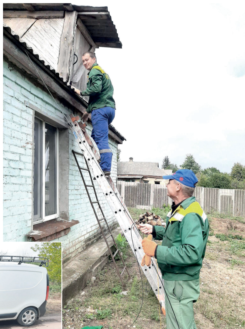
прокладають кабелі в приватні помешкання жителів Володимирівки. Дехто попросив завести кабель через горище, і монтери виконали це побажання.
