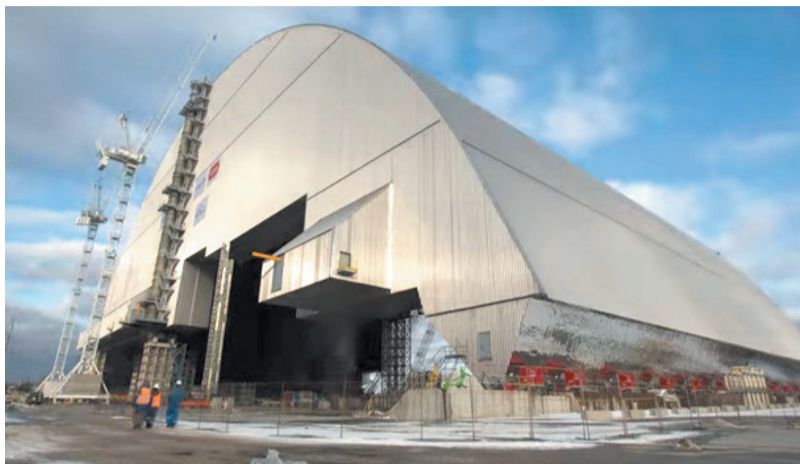
Герметична захисна арка над 4-им енергоблоком ЧАЕС, встановлена в 2016 році
